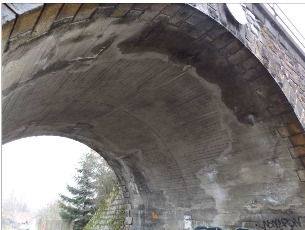
Obr. č. 6 - pohled na nosnou konstrukci - klenbu. Za oběma čely dochází k průsakům vody. V místech průsaků dochází k degradaci a opadáním povrchové vrstvy betonu.
