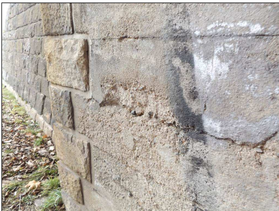
Obr. č. 8 - pohled na pracovní spáru v líci vybrané opěry a opadání betonu, který podléhá vlivům koroze
