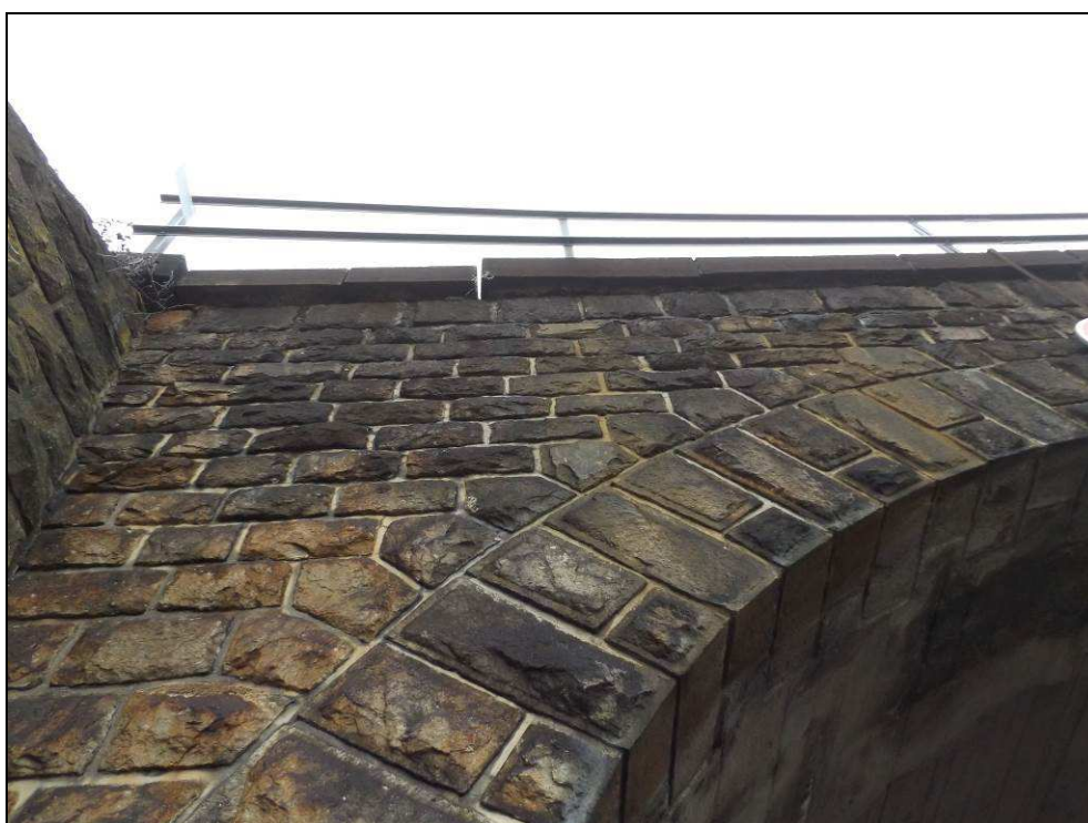
Obr. č. 10 - pohled vychýlené kamenné kvádry vybrané římsy objektu
